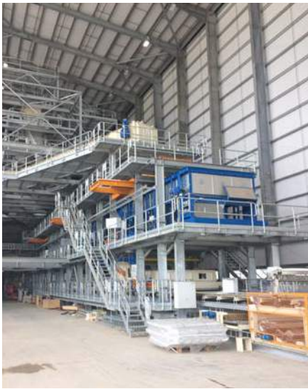
Auch die OSB-Streustation wurde durch KSI montiert
