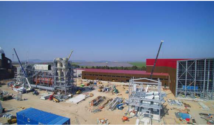
Die Norbord-Baustelle in Inverness, Schottland
