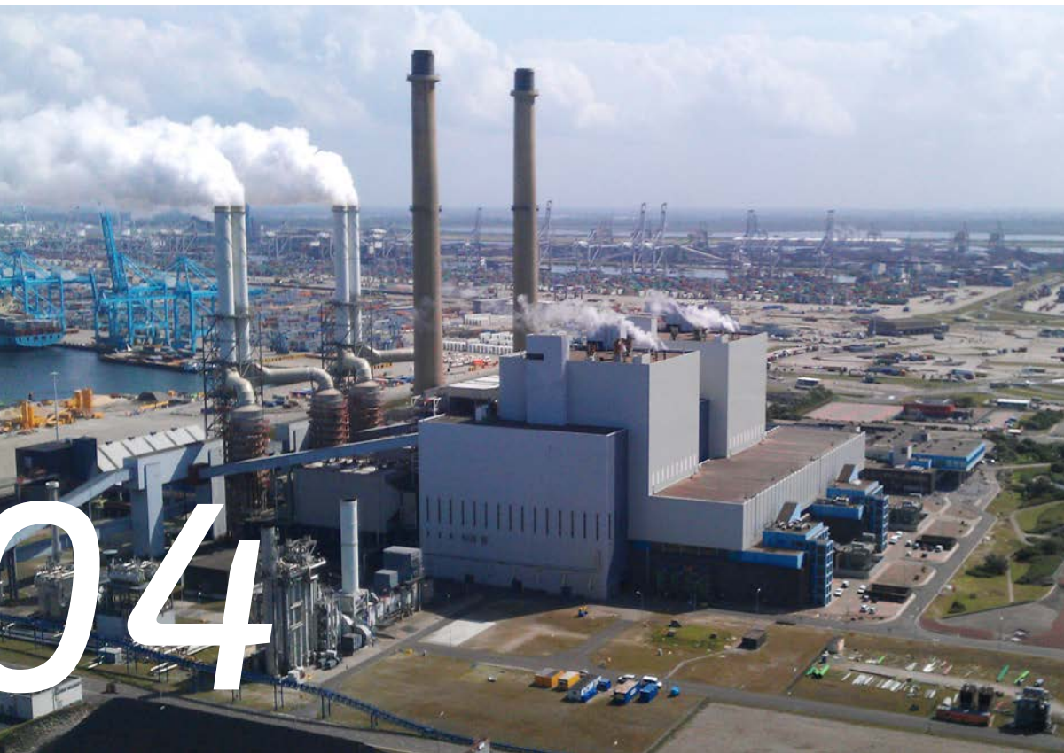
Im Auftrag von Mitsubishi Hitachi Power Systems Europe montierte KSI vier Kohlemühlen in Rotterdam
