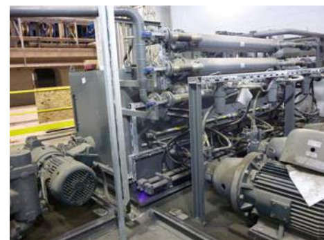
Auch die Hydraulikstation wurde in Kanada demontiert
