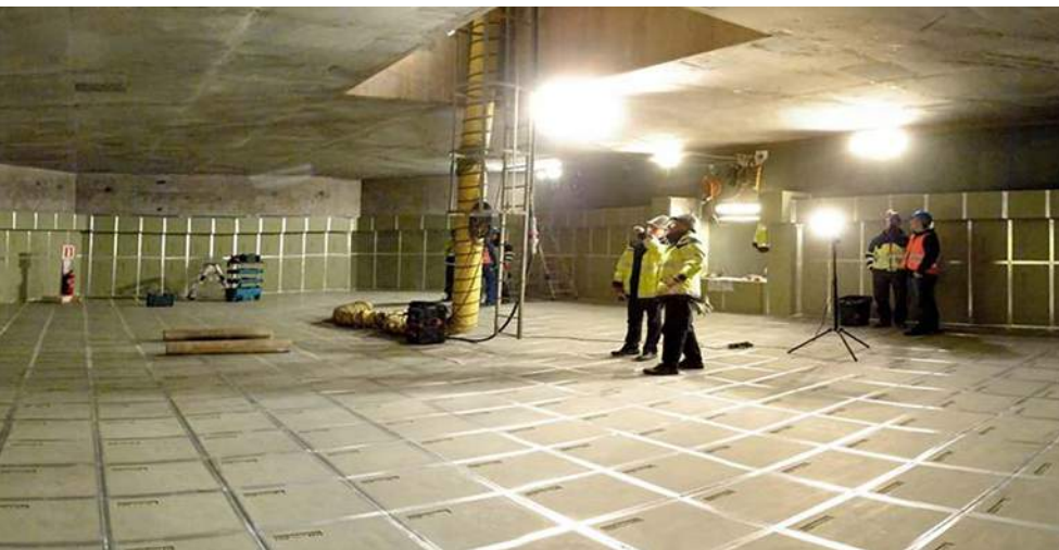
Fast fertig: Begutachtung des Montagefortschritts
