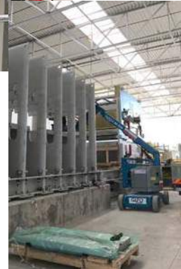
Montage der ersten Pressenrahmen
