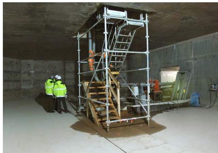
Unter dem Reaktor: der „Spreading Room“ im Rohzustand
