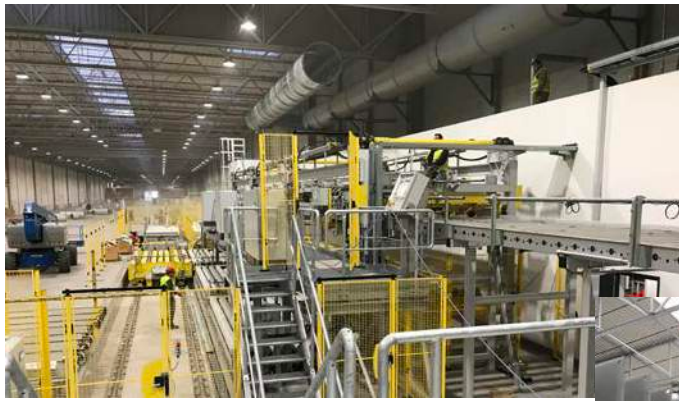
Die Schleifstraße hinter der Presse wird montiert
